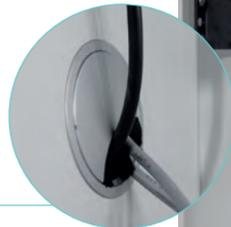
• Je eine Bohrung mit Abdeckung (Ø ≈ 80-100 mm) pro Lagerbereich in den seitlichen Innenwänden (gesamt 10 Stück)
